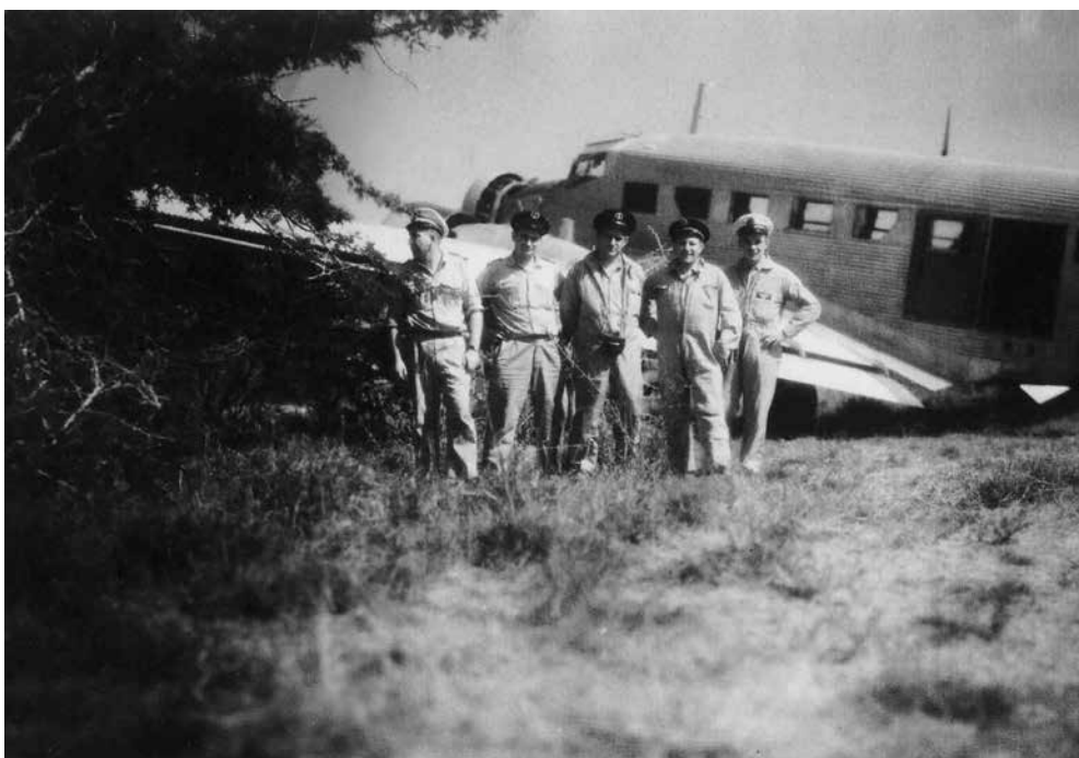
Ju 52 de la Marine dans le décor à Dakar-Ouakam le 4 janvier 1959, défaillance des freins
