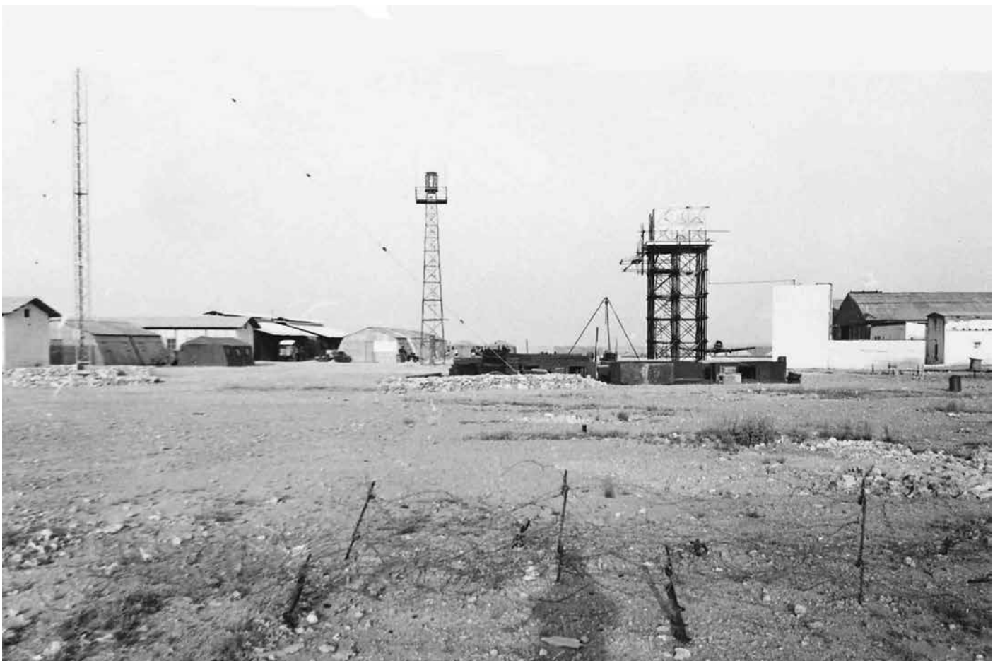
▼ Les deux châteaux d'eau
